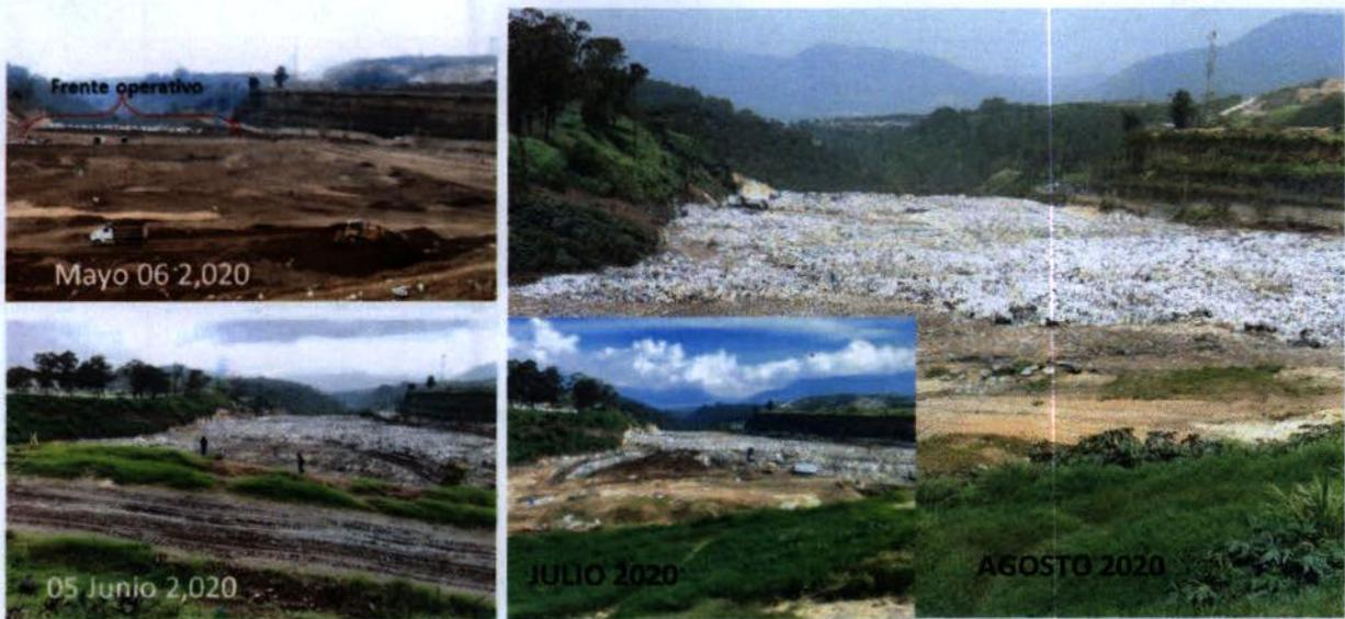
**Fotos 10-13:** Sin las horas adecuadas de maquinaria pesada y bajo las condiciones climáticas que imperan en el territorio nacional, existen complicaciones técnicas operativas, provocando impactos negativos y carencia de áreas adecuadas para descargas. A diferencia de contar con la maquinaria necesaria, los impactos negativos se minimizan y el frente operativo puede ser ordenado y sistemático (como se observa en el mes de mayo 2020).
