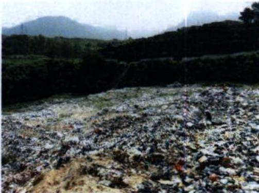
**Fotos 5-9:** Ingreso de vehículos recolectores y los impactos negativos que se observan por no contar con suficientes horas de maquinaria pesada para realizar la operación de distribución, compactación y coberturas diarias.
