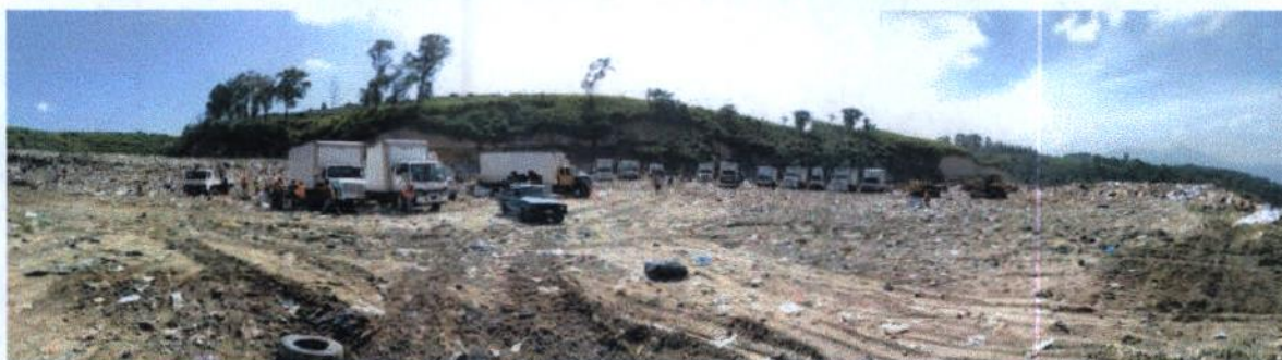
Fotos 14-15: Frente operativo donde se observa la descarga de residuos sólidos. Actualmente por contar con maquinaria pesada de parte de AMSA, se ha mejorado las plataformas y se propicia una descarga más ordenada y sistematizada, la cual deberá de mejorar de acuerdo al avance operativo.
