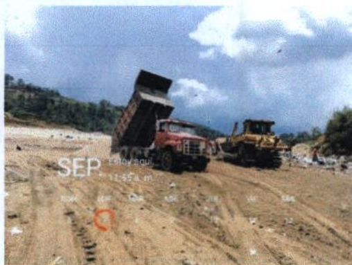
Fotos 16-17: Corte, carga y traslado de material de cobertura dentro del vertedero controlado
