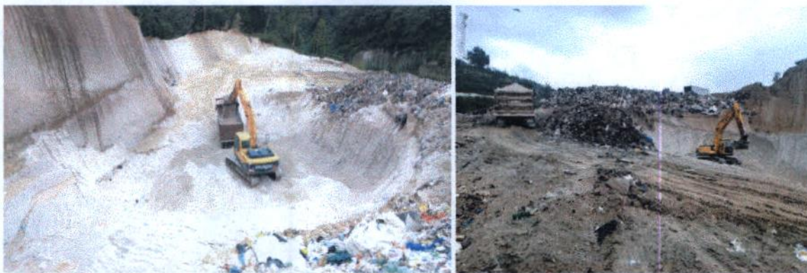
Fotos 16-17: Corte, carga y traslado de material de cobertura dentro del vertedero controlado
