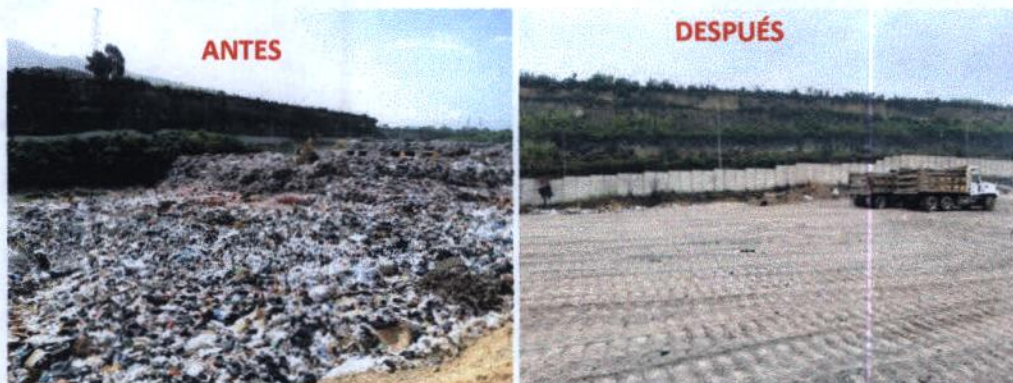
Fotos 3-8: Ingreso de vehículos recolectores y los impactos negativos que se observaban por no contar con maquinaria pesada. Sin embargo a través de la coordinación técnica se están realizando los trabajos de distribución, compactación y cobertura, minimizando los impactos negativos que se han observado por lo general cuando no se cuenta con maquinaria pesada.
