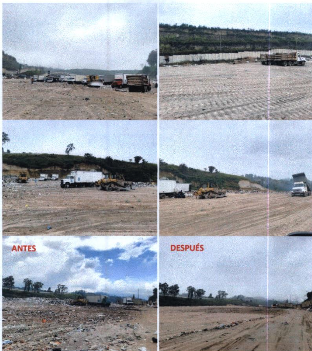
Fotos 23-28: Trabajos de distribución, compactación y cobertura de los residuos sólidos.
