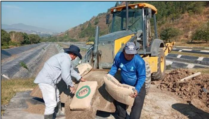
*Imagen 14, Resanado de taludes de biofiltros dañados*
