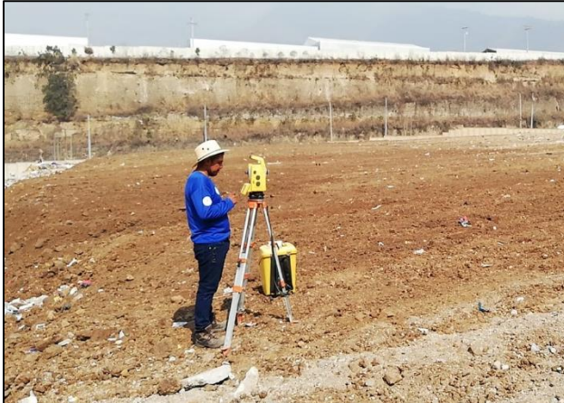
18 de abril de 2022 Vertedero Km 22 Levantamiento topográfico
